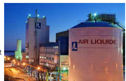
Foto: Air Liquide industriële centrale
